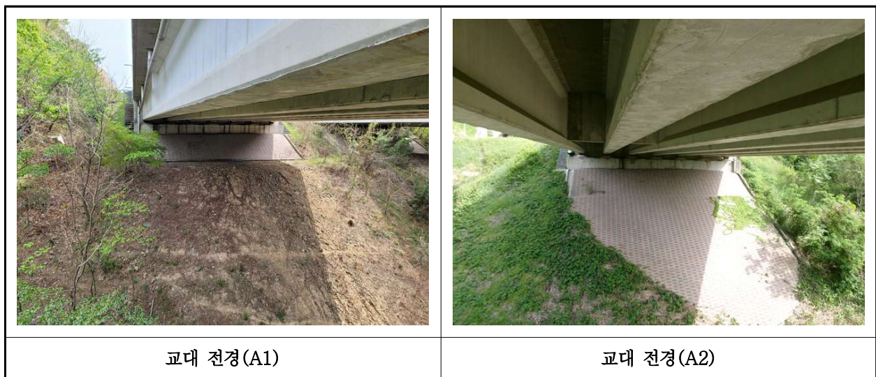
【사진 14.3.8】 교대 전경
