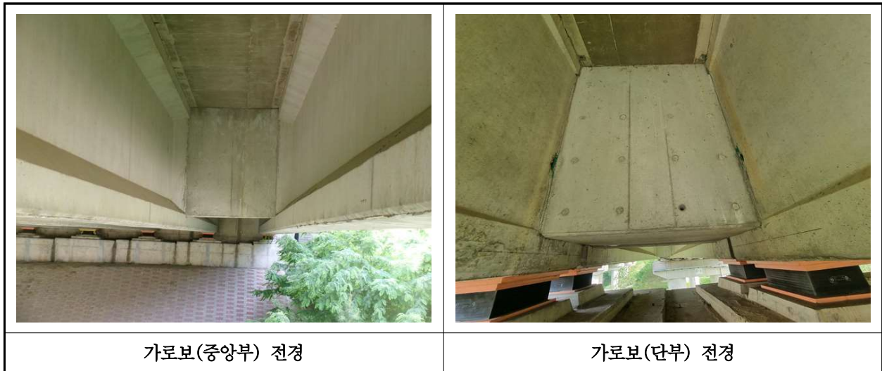
【사진 14.3.6】 가로보 전경
