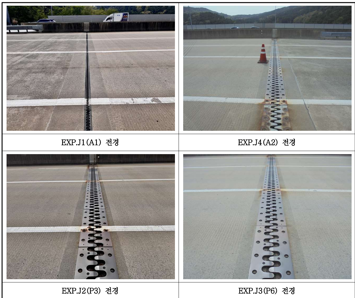
【사진 14.3.17】 신축이음장치 전경
