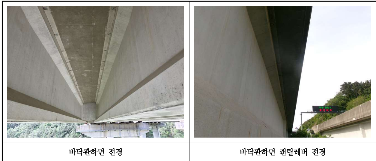
【사진 14.3.2】 바닥판하면 전경
