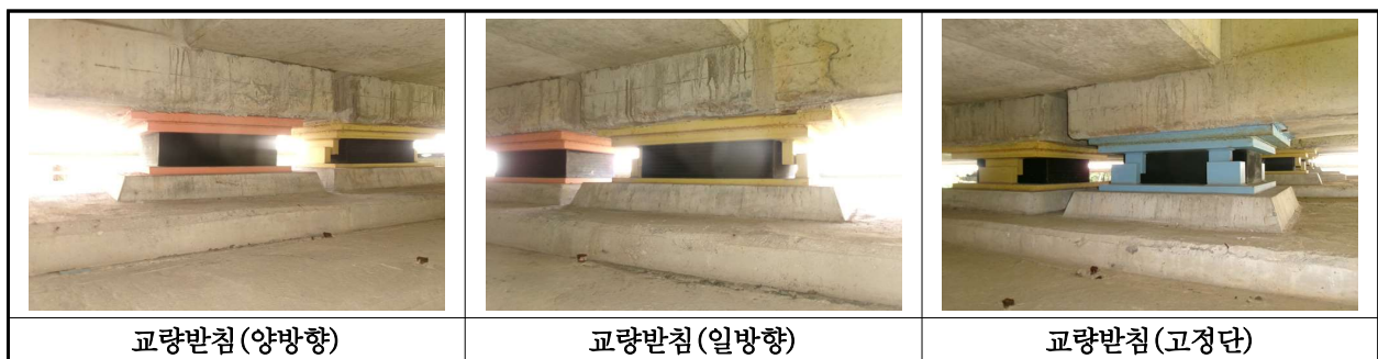
【사진 14.3.13】 교량반침 전경
