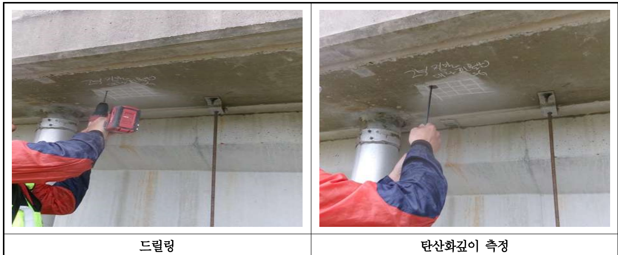
【사진 14.4.3】 탄산화 깊이 측정 현장사진
