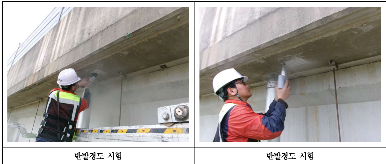
【사진 14.4.2】 반발경도시험 현장사진
