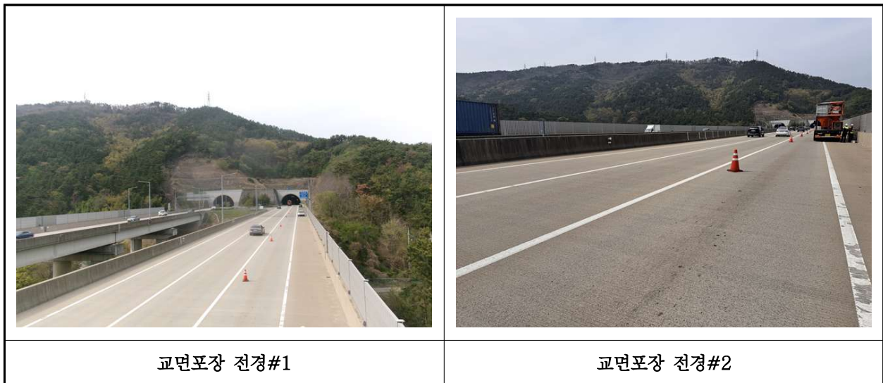
【사진 14.3.20】 교면포장 전경
