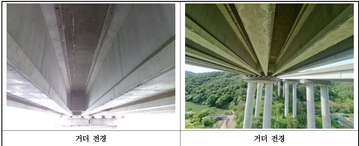
【사진 14.3.4】 거더 전경
