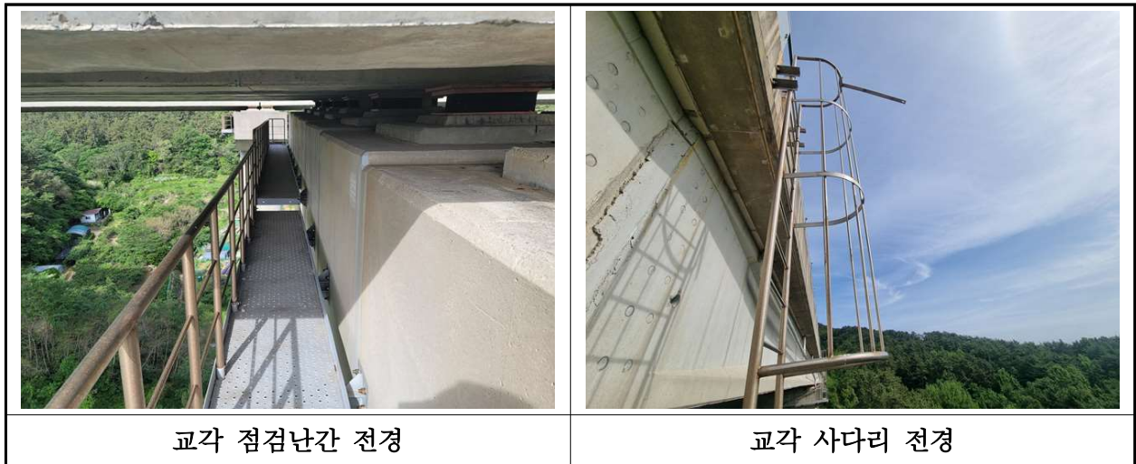
【사진 14.3.26】 교량 점검시설 전경
